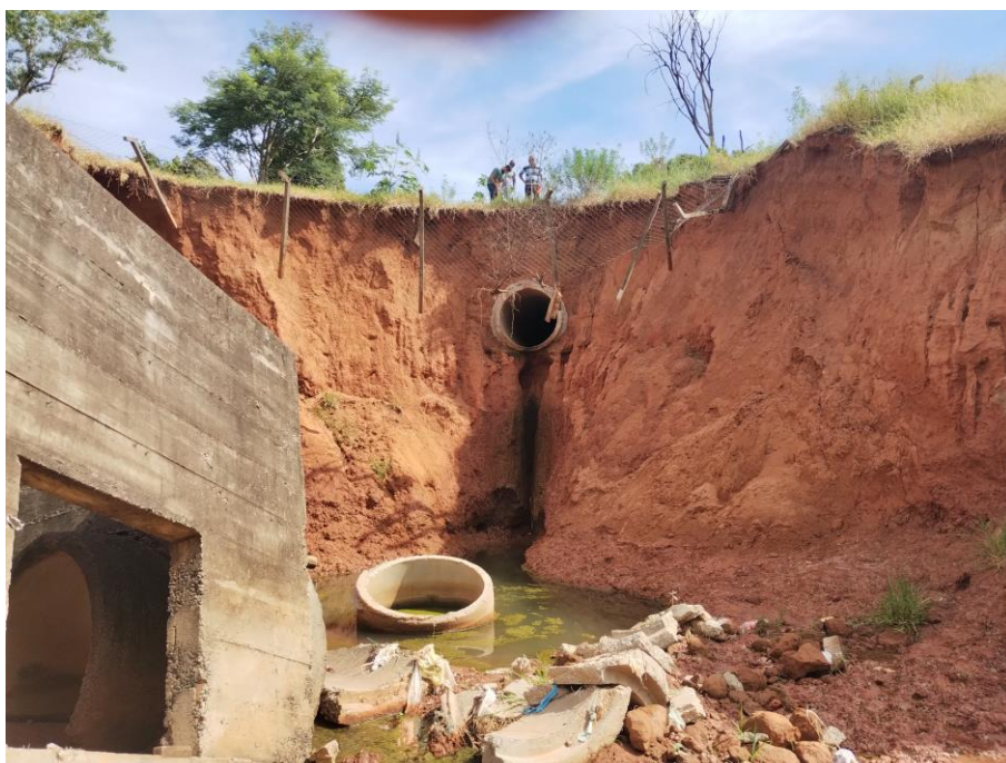
Foto 1 – Tubulação de chegada e dissipador de entrada arrastado e solo exposto em processo erosivo
