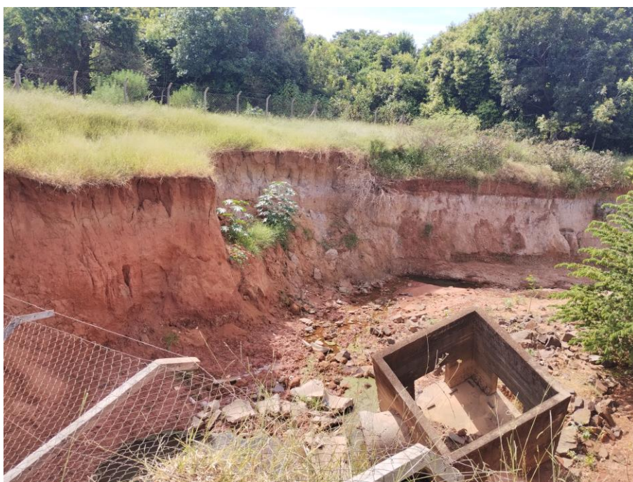
Foto 2 – Vista superior da Entrada da bacia de detenção e solo exposto em processo erosivo
