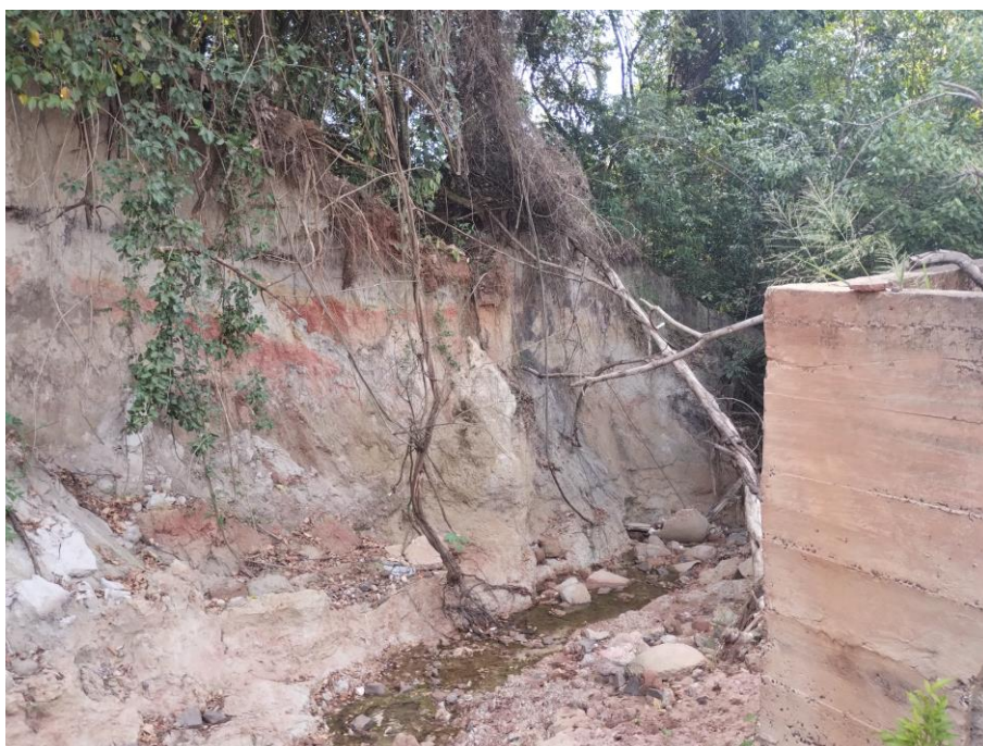
Foto 3 – Vista do dissipador de energia na saída da Bacia de detenção e processo erosivo do solo
